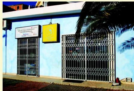
Il cancelletto estensibile è realizzato con speciali profili a "U" in acciaio zincato ed è dotato di una serratura a chiave tipo Yale.
